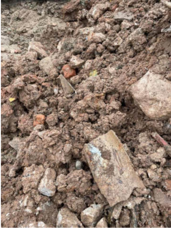
Abb. 3: Schurf SCH 1, Untere Auffüllung, Boden mit Bauschutt (Beton-, Ziegelbruch) und etwas mehr Müllanteile (Kunststoff), außerdem Bruchstücke von Eternitplatten.
