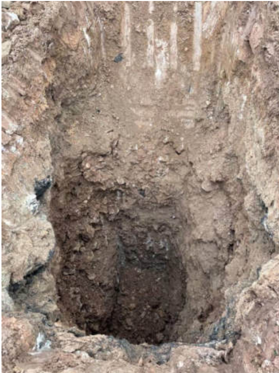
Abb. 11: Schurf SCH 4, Untere Auffüllungsschicht. Bauschuttanteil nur gering (ca. 1-3 %). Ab. ca. 3,0 m augenscheinlich kein Bauschutt mehr erkennbar.
