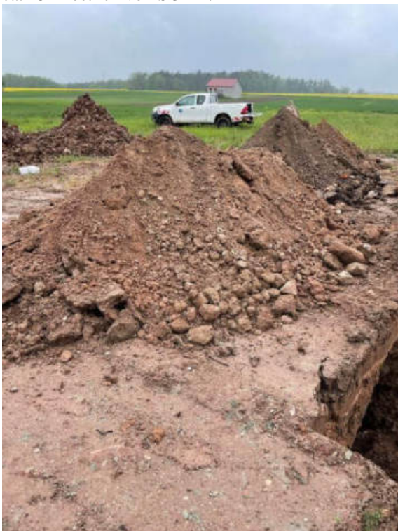
Abb. 20: Schurf SCH 7, obere Auffüllungsschicht (bis 1,5 m). Bauschuttanteil nur gering in Form von Beton- und Sandsteinresten
