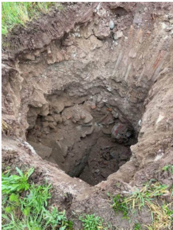
Abb. 16: Schurf SCH 6, östliche Abbaugrenze Steinbruch (jüngerer Teil). Stark bauschutthaltige Auffüllungen (ca. 50 %) bis ca. 6,40 m u. GOK.
