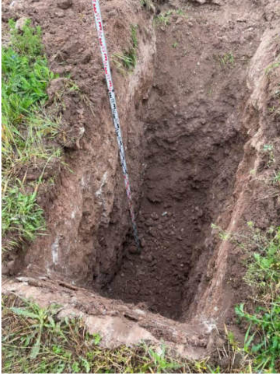
Abb. 5: Schurf SCH 2, Untere Bodenschichten, ebenfalls ohne erkennbare Bauschuttanteile
