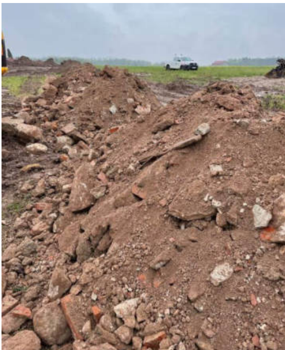
Abb. 18: Schurf SCH 6, untere Auffüllungsschicht (2,0 -6,40 m). Bauschuttanteil bei ca. 50 %. Überwiegend Ziegel-, Beton- und Sandsteinbruch. Untergeordnet Müll (Folien)
