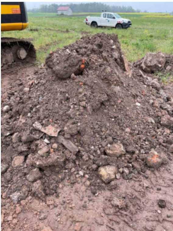
Abb. 8: Schurf SCH 3, untere Auffüllungsschicht. Bauschuttanteil (Beton, Ziegel) etwas höher, Müllanteil (Schrott, Glas) relativ gering
